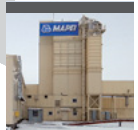
Завод пос. Кикерино, Ленинградская обл.
