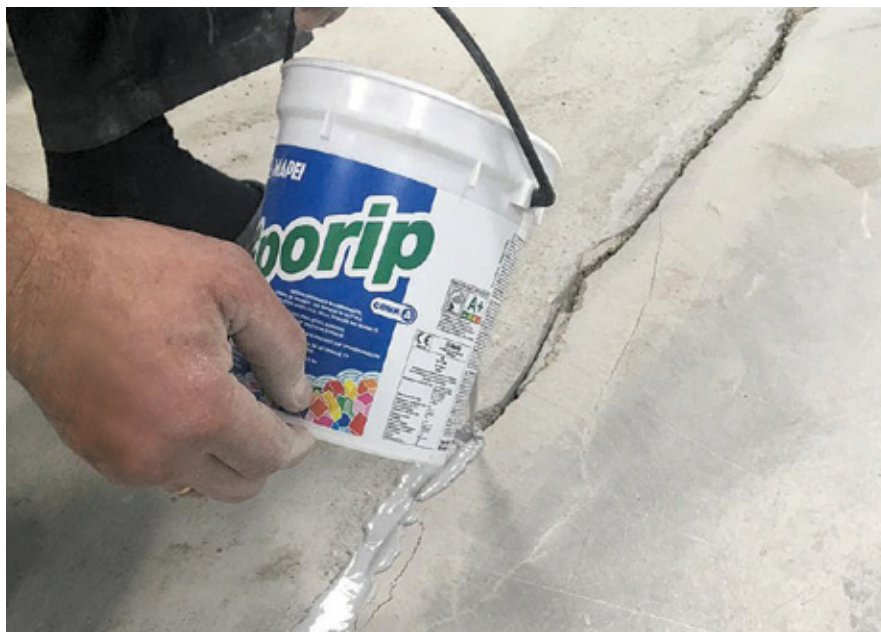
Заливка трещин в основании с помощью Eporip
