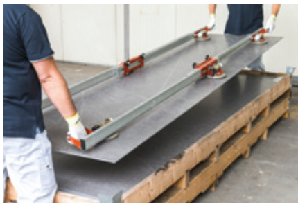
Правильное перемещение плитки
