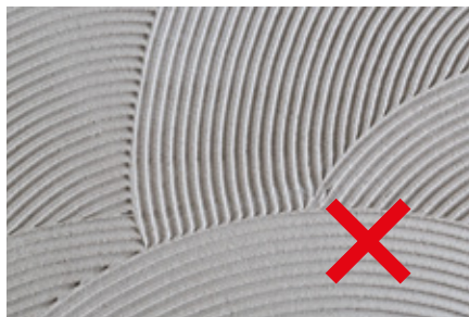
Правильное и неправильное нанесение клея
