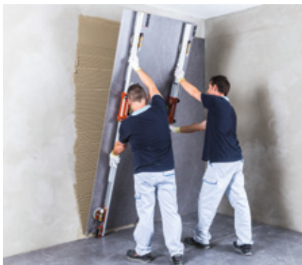
Укладка плитки на стену
