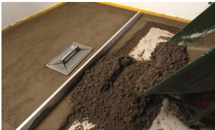
Укладка стяжки на основе Торсеп Pronto
