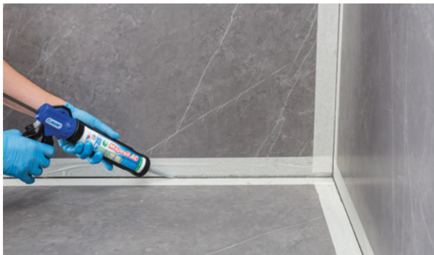
Герметизация шва по периметру с помощью Mapefil AC
