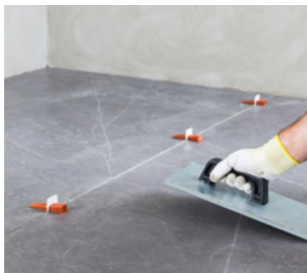
Простукивание плитки вручную или с помощью вибропанели
