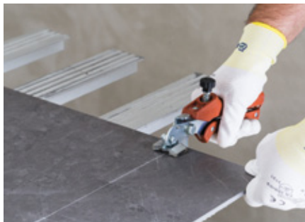
Разламывание плитки с помощью щипцов для надлома
