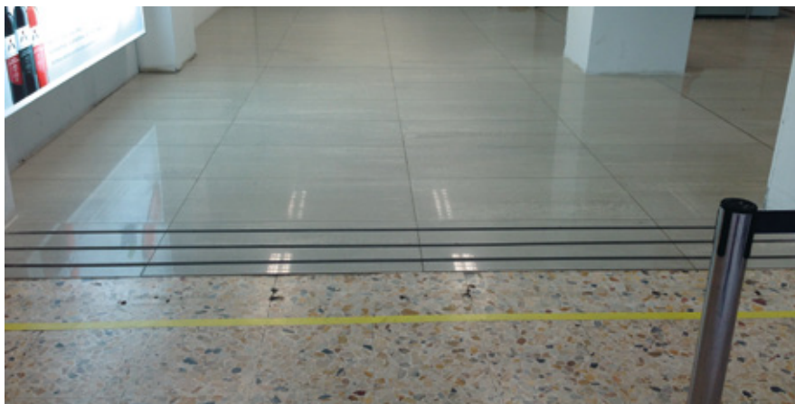
Укладка плитки поверх существующих полов
