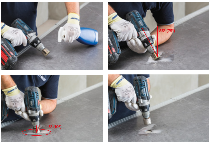
Порядок действий по созданию круглого отверстия
