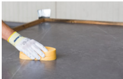
Очистка поверхности плитки
