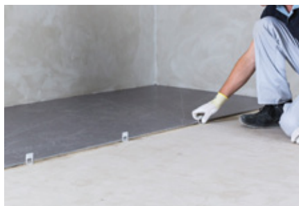
Установка разделителей в требуемое положение
