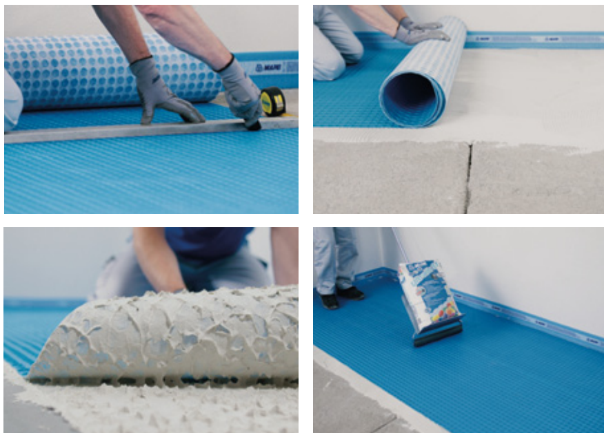
Процесс укладки Mapeguard UM 35
